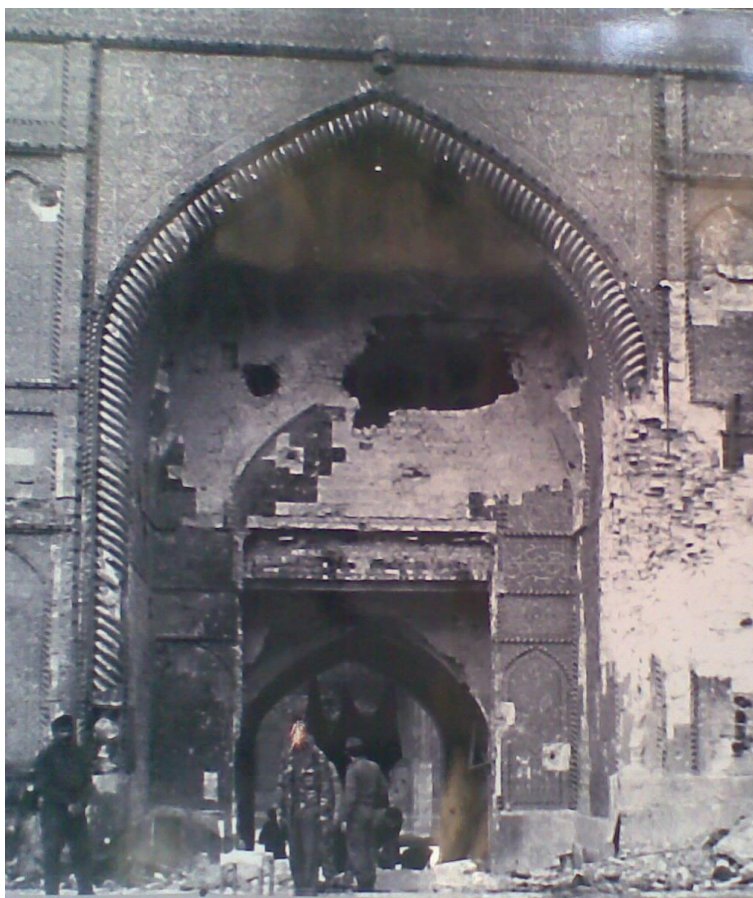
Endommagement du mausolée de l'Imam Hussein en 1991
